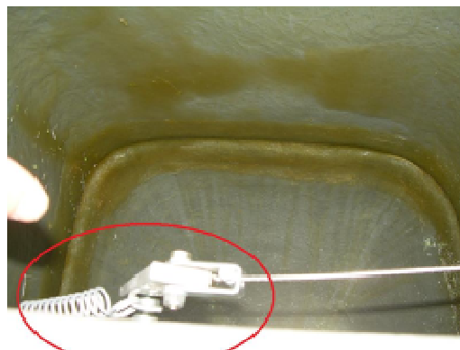
Comprobación del recorrido de la compuerta desviadora de flujo en el interior del depósito.
